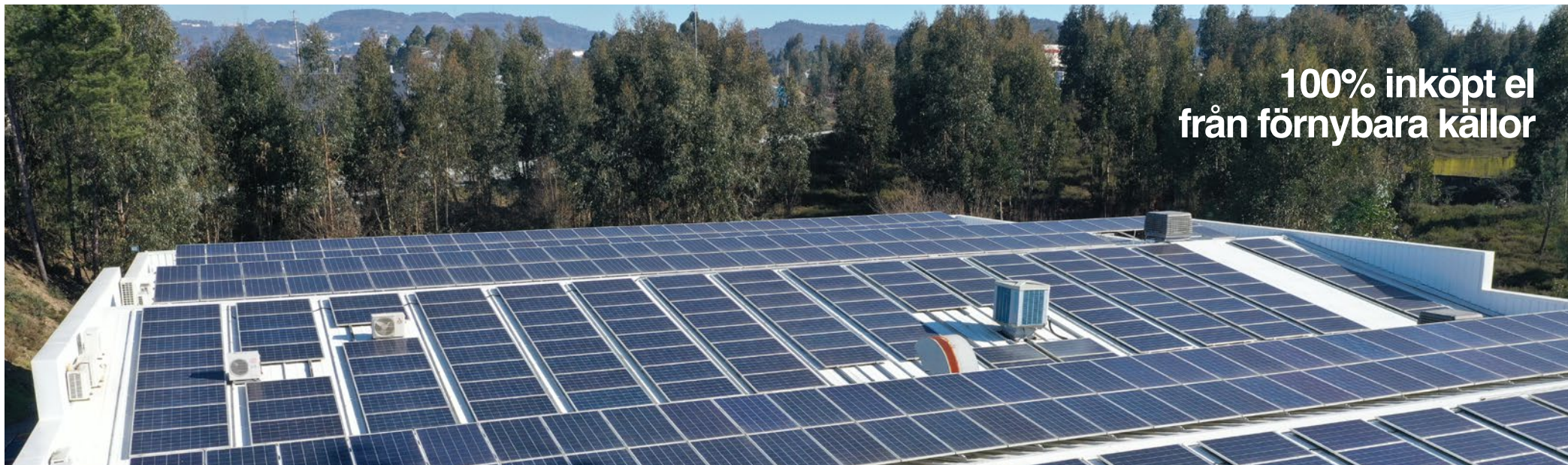
Nilörn Portugals fabrikstak är täckt med solpaneler
